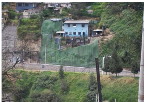
Fotografía 1. Ladera revestida con TERRATRAC TRM 15
