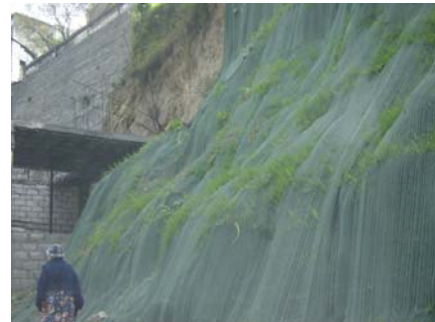
Fotografía 2. Manto TERRATRAC TRM 15 instalado
